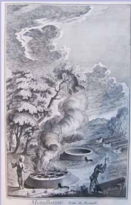
Fig. 1. Tavola dalla Encyclopédie di Diderot e D'Alembert.: Metallurgie, Fonte du Bismuth , collezione privata
