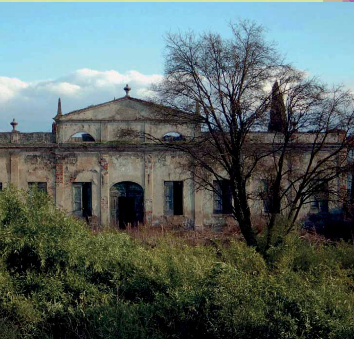
La limonaia, dall'elegantissima facciata, e il giardino della villa Baldi in stato di completo abbandono
