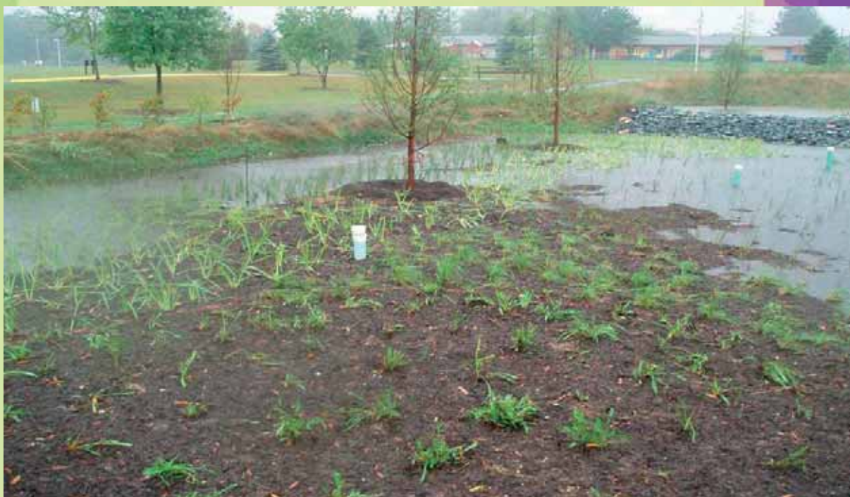
Area progettata per la bioritenzione degli eccessi idrici
