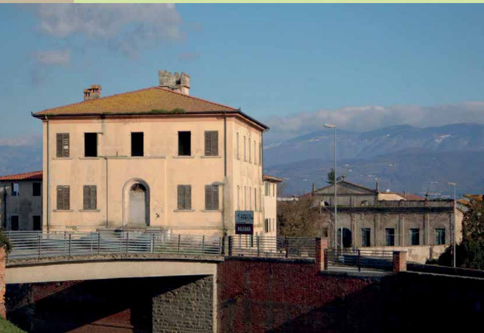
La villa Baldi alla Ferruccia in condizioni di forte degrado
