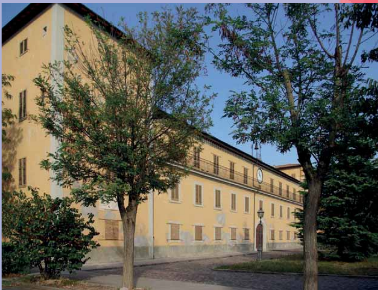
Fig. 4 a - Edificio delle saline di Stato presso Saline di Volterra
