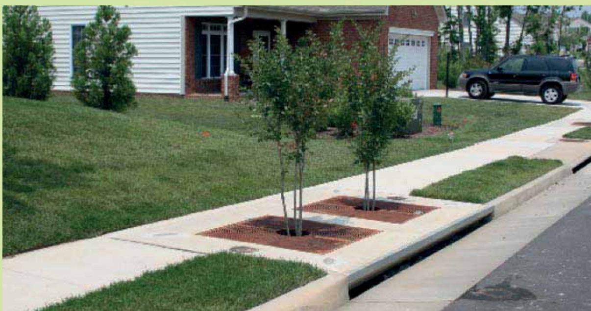
Tree Box Filters lungo un marciapiede in Virginia USA 3
