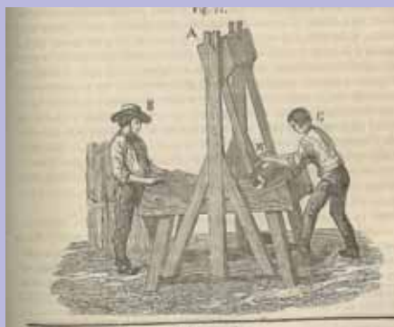
Una macchina impiegata nell'800 per accelerare il lavoro di sfibratura tradizionalmente realizzato con le mazze.
