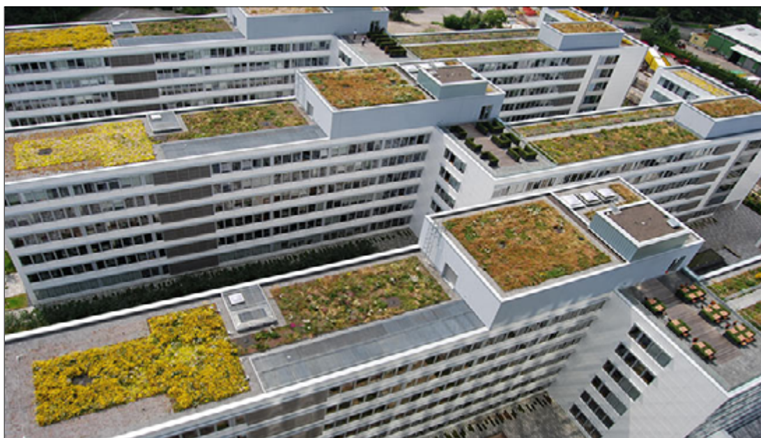
Fig. 1. Esempio di giardini pensili su tetti di edifici - Foto da Internet.
