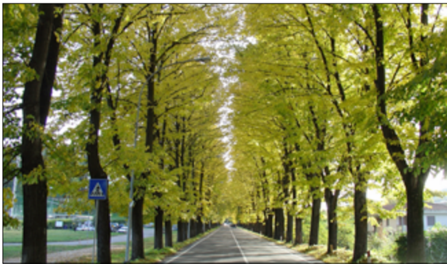
Fig. 3. Strada statale n. 222 nei pressi di Grassina (Firenze), foto autunnale prima della potatura (Foto F. Ferrini)
