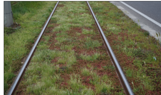
Fig. 2. Particolare di utilizzo di Sedum tra i binari nella tranvia di Firenze. - Foto M. Afferni.
