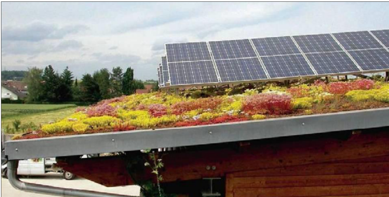
Fig. 6. Utilizzo di tappeti di Sedum su tetti. - Foto da Internet.
