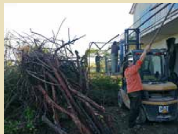
Foto 6 Messa in sicurezza dei pali del pergolato
