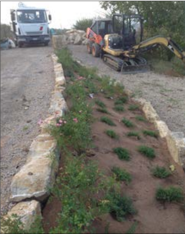
Pacciamatura con fibra di cocco, ala gocciolante sottostante e finitura con pietre locali drenanti
