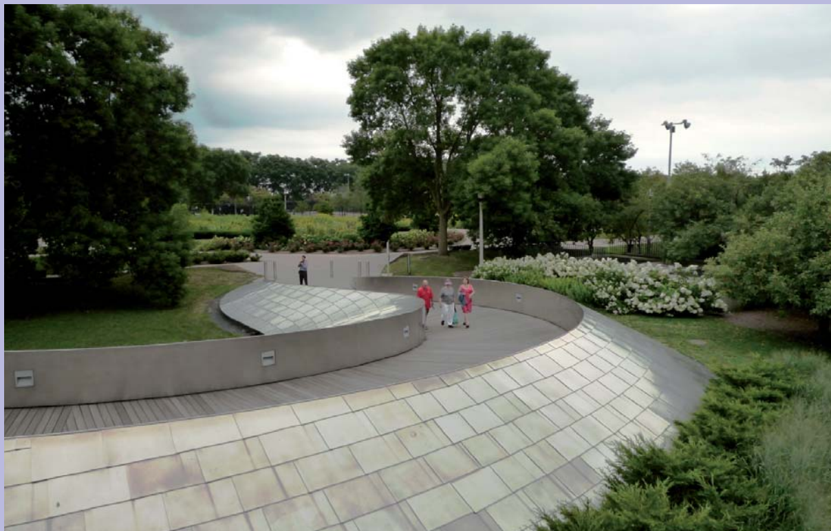
BP Pedestrian Bridge, progettato da Frank Gehry, che collega il Millennium Park al Daley Bicentennial Plaza
