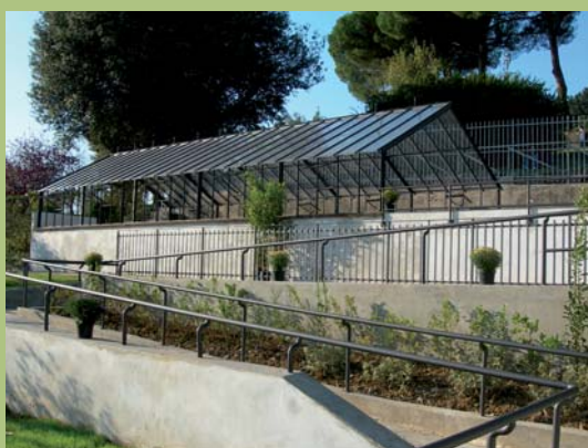
Fig. 4 La serra ed il percorso di accesso al nuovo spazio pubblico
